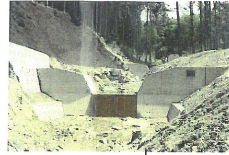
下流側から見た3基の設置状態
