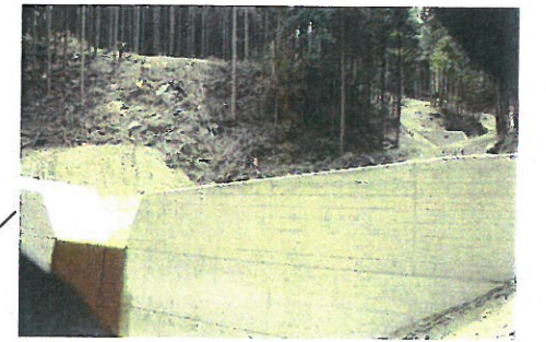
下流側から見た3基の設置状態
