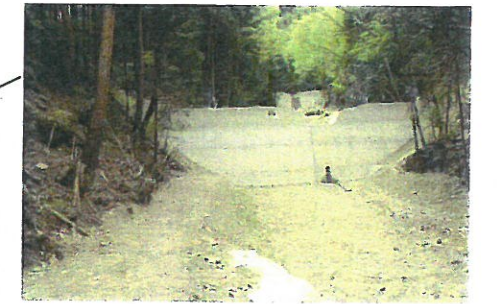
下流側から見た2基の設置状態
