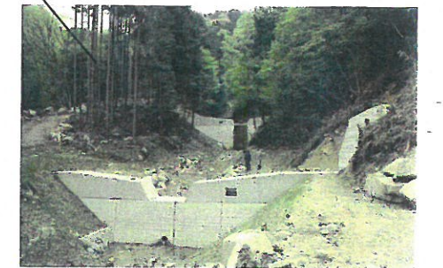
下流側から見た3基の設置状態
