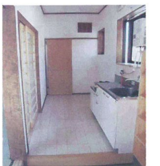
地域環境整備事業 事例 ■上中町集会所改修事業助成
