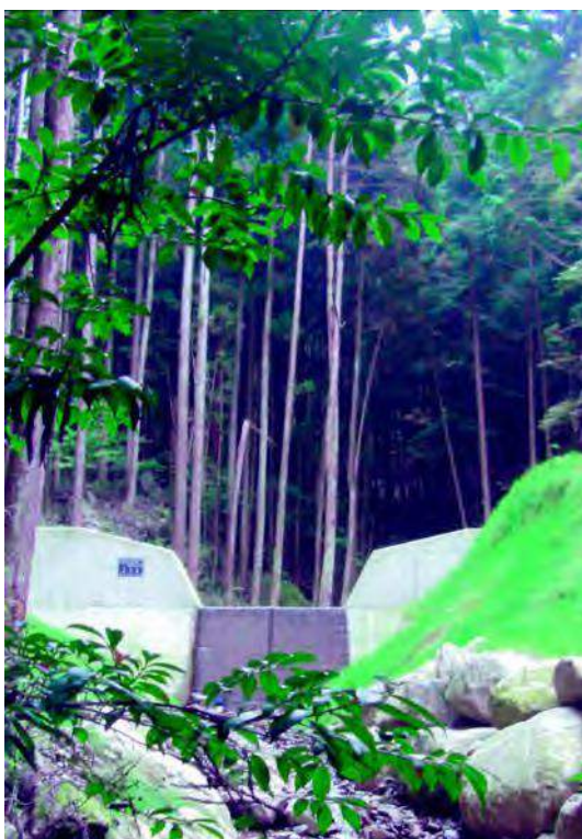
◆地域安全防災対策事業（治山）
