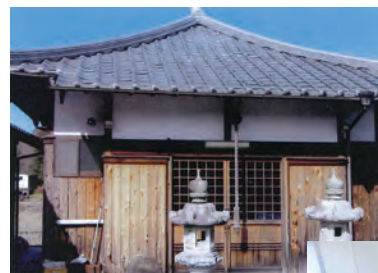
坂本4の2区 ← 薬師堂仏像群改修及び一部耐震補強工事
