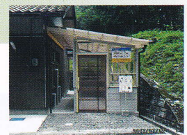
3区広久手組集会所ゴミステーション新設工事 (助成事業)
