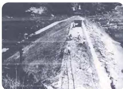
完成間近い源根溜池工事風景
