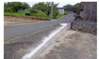
2：下洗井墓地通路路肩
